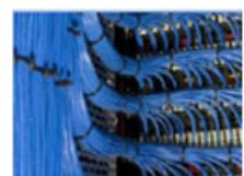
Una gran ventaja de las cámaras IP reside en el cableado, donde no es necesario tirar un cable desde la cámara hasta el DVR, ya que estas cámaras se conectan directamente a la Red Alámbrica o inalámbrica de la empresa y el software en el NVR es el encargado de hacer la conexión "lógica" con la cámara. El estándar el mercado para la distancia máxima de cableado (en el caso de la ip, de la cámara al nodo de red) es de 330 Pies.
